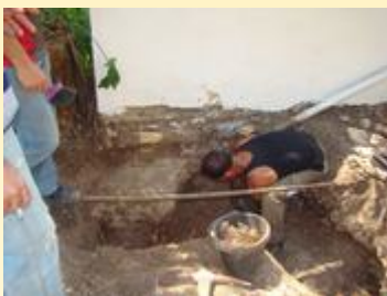
Imagen 2. Realización de la cala SC011-002 en la esquina sur-este del aljibe del patio central del primer claustro.
