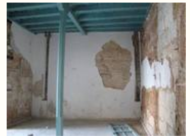
Imagen 8. Local del segundo claustro donde se encuentran interesantes transformaciones constructivas. Como resultado del trabajo del equipo que lo estudió se identificaron cuatro momentos constructivos. El más importante y punto de partida, la construcción de un muro en el que quedaron embebidos los pies derechos de la galería este del claustro.
